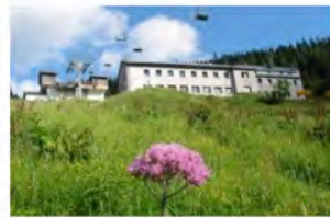
Ötscherschutzhaus Am Ötscher 1 3295 Lackenhof
